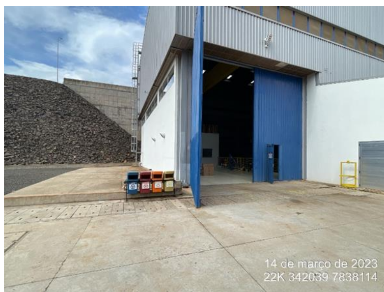
Figura 3.12.2-1: Lixeiras localizadas na casa de hóspedes e casa de força com identificação para segregação. Amarelo – Metais, Azul – Papéis, Vermelho – Plásticos, Laranja – Resíduos Perigosos. PCH Areado, Água Clara, MS. Março de 2023.
