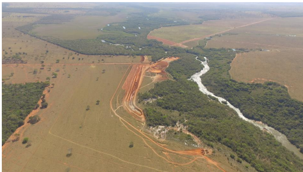
Figura 3-3: Caracterização da área que será instalado o Canal de Adução da futura PCH Fundãozinho, além da caracterização das propriedades vizinhas. PCH Fundãozinho, Paraíso das Águas, Mato Grosso do Sul. Agosto de 2023.
