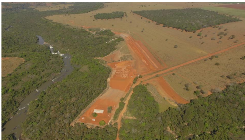
Figura 3-2: Caracterização do Canteiro de Obras e da área que será instalado o Canal de Adução da futura PCH Fundãozinho, além da caracterização das propriedades vizinhas. PCH Fundãozinho, Paraíso das Águas, Mato Grosso do Sul. Agosto de 2023.
